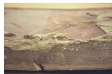
Affaissement dû à la cassure centrale
